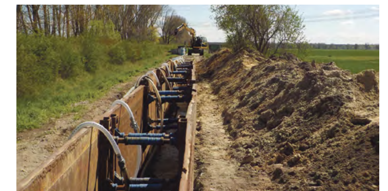
Verlegung der Abwasserdruckleitung in Oberkrämer.
