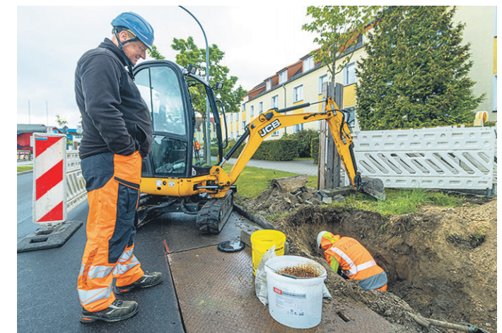
In der Finkenkruger Straße in Falkensee erneuert die Firma Tief- und Wasserbau Boblitz einen Schmutzwasserkanal. Weil der Kanal im unterirdischen Vortrieb eingezogen wird, sind Verkehrseinschränkungen nur punktuell nötig.
