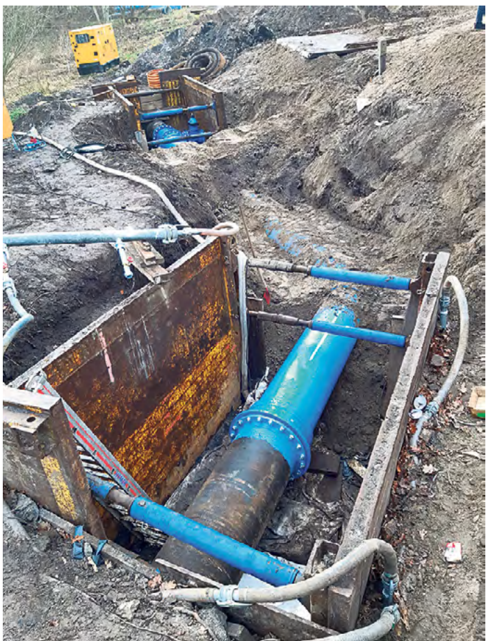
Nach den Arbeiten wurden die Leitungsenden verbunden. Fotos (2): OWA
