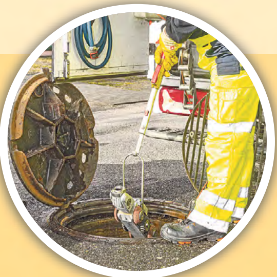
Behutsam versenkt der Kollege die Kamera durch den Abwasserschacht in die Kanalisation.
