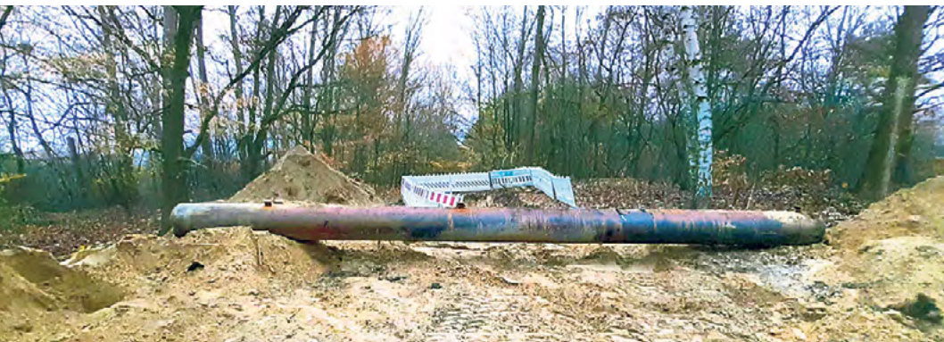
Nach fast 50 Jahren im Einsatz darf die alte Stahlleitung am Falkenhagener See in Rente gehen.
