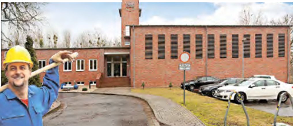
Im Wasserwerk Hennigsdorf wird ab 2018 massiv gebaut.
