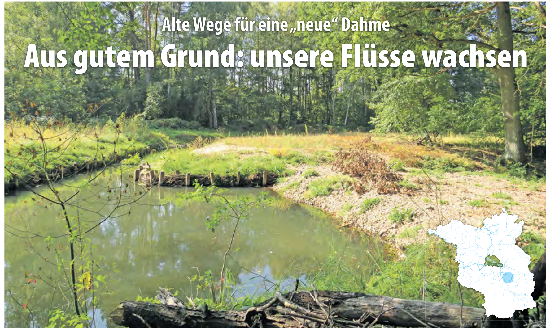
Genau an dieser Stelle wurde die Dahme-Begradigung (rechts im Bild) verschlossen und der Weg in den Altarm wieder geöffnet. Dieser verlängert nun den Verlauf der Dahme um 150 Meter.
