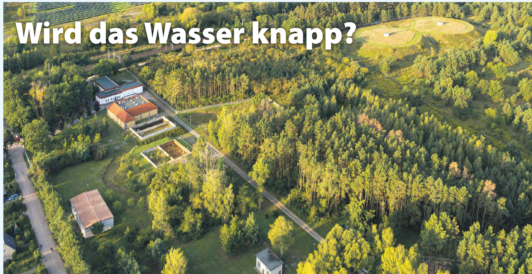
In Staaken (hier die Ansicht vom Wasserwerk) wurden Grundwasservorkommen ermittelt, die auch einen wachsenden Trinkwasserbedarf decken können.
