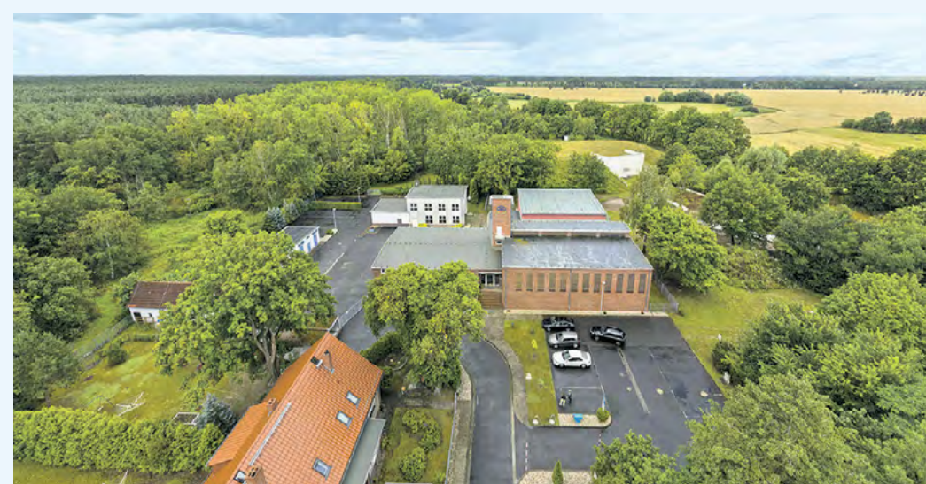
Für das Wasserwerk Hennigsdorf gibt es langfristig sicheres Grundwasser.
