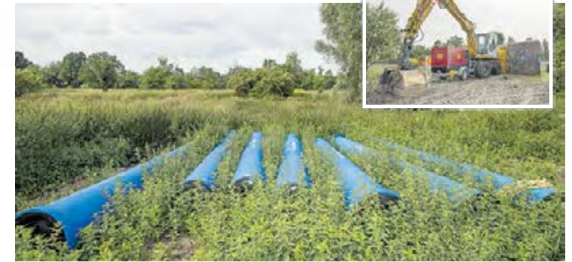
Warten hier noch auf Ihren Einsatz: Diese Trinkwasserleitungen mit einem Durchmesser von 60 cm transportieren in Kürze das Trinkwasser vom Wasserwerk Staaken nach Hennigsdorf.
