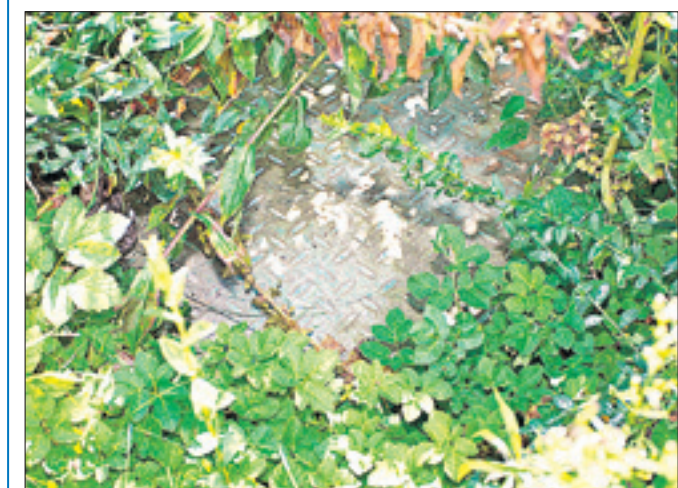
Nur mit viel Spürsinn zu finden: ein „überbautes“ Hauspumpwerk.
