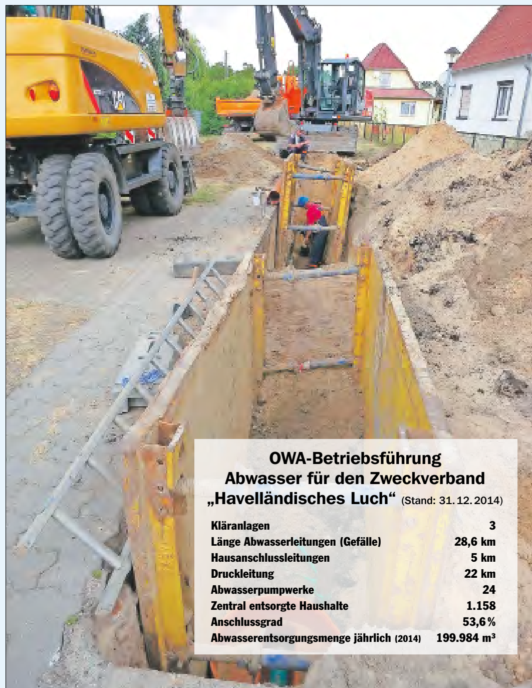
Start der Erschließungsarbeiten für die neuen Abwasserrohre im Warsower Luchweg. Foto: OWA/Konstantin Grützer
