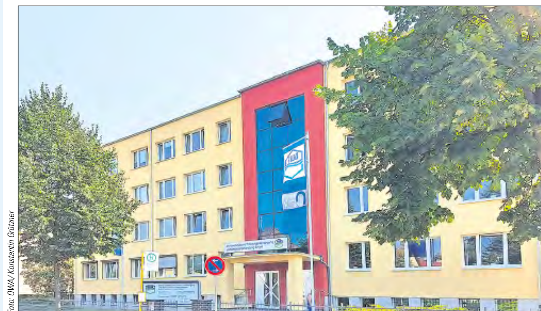
Nicht nur die Fassade strahlt in neuem Glanz, auch die Energiebilanz für den Firmensitz der OWA hat sich durch eine Dämmung des Daches wesentlich verbessert.
