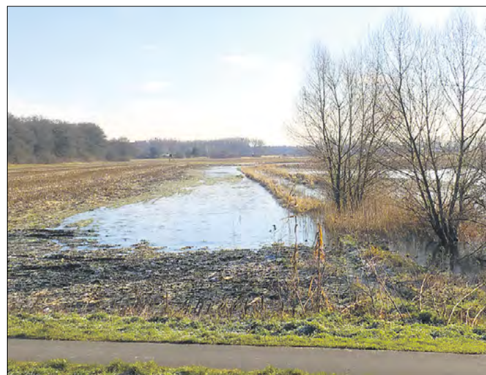
Wenn die Gräben nicht gepflegt werden, sehen sie aus wie das Grabensystem vor Nauen an der B273. Fotos (2): Gemeinde Schönwalde-Glien
