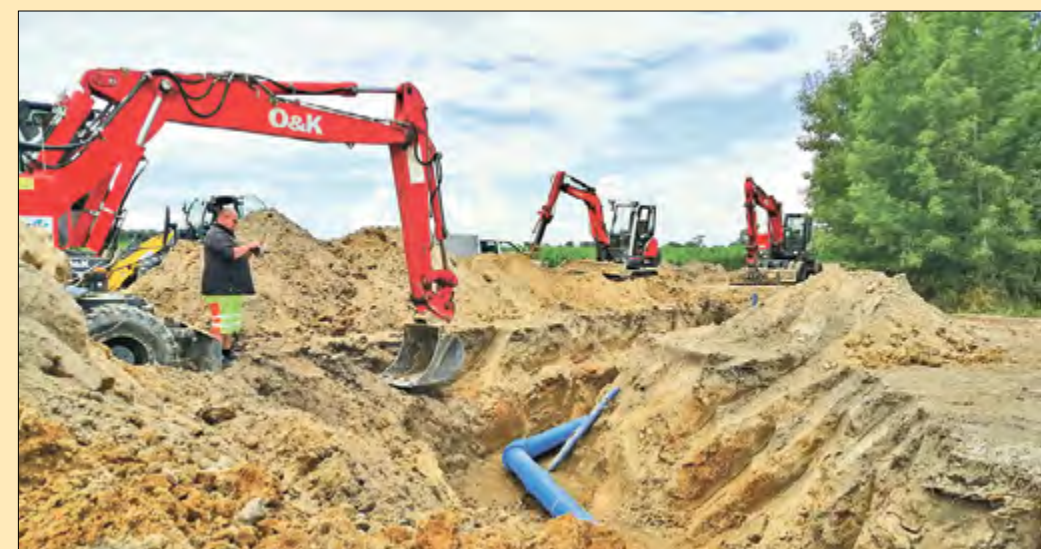
Direkt neben der Straße wurde die neue Leitung verlegt, die nun einen größeren Durchmesser von 300 mm hat.
