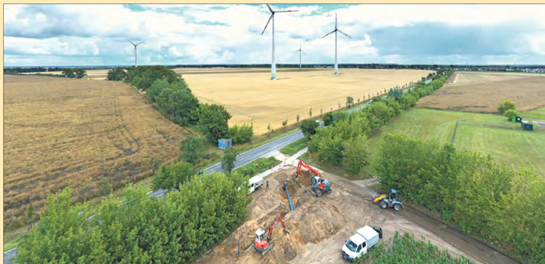
Direkt neben der Straße wurde die neue Leitung verlegt, die nun einen größeren Durchmesser von 300 mm hat.
