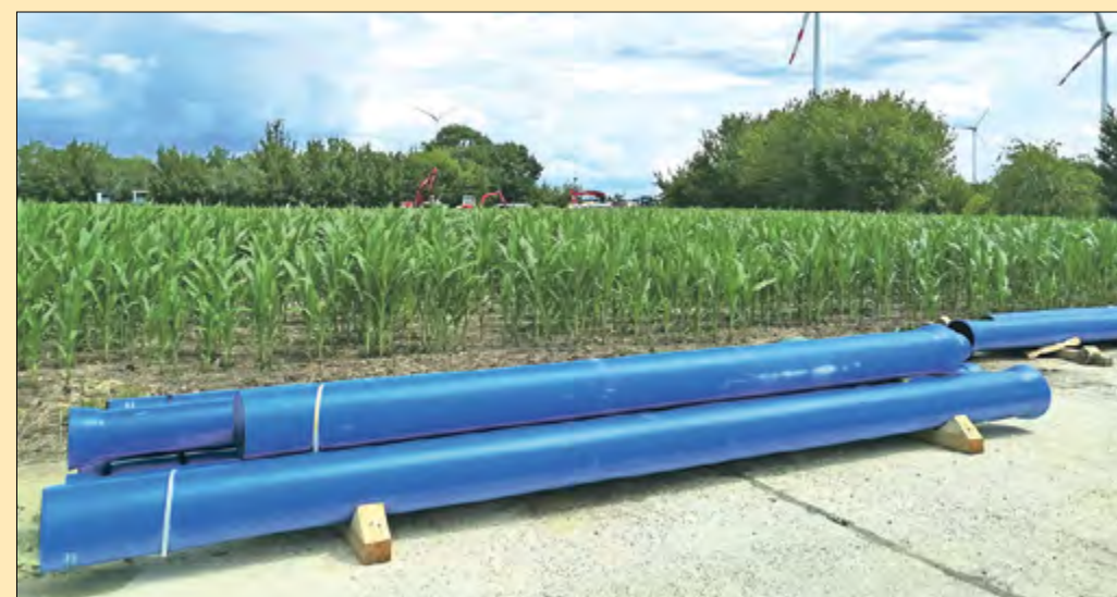
Direkt neben der Straße wurde die neue Leitung verlegt, die nun einen größeren Durchmesser von 300 mm hat.
